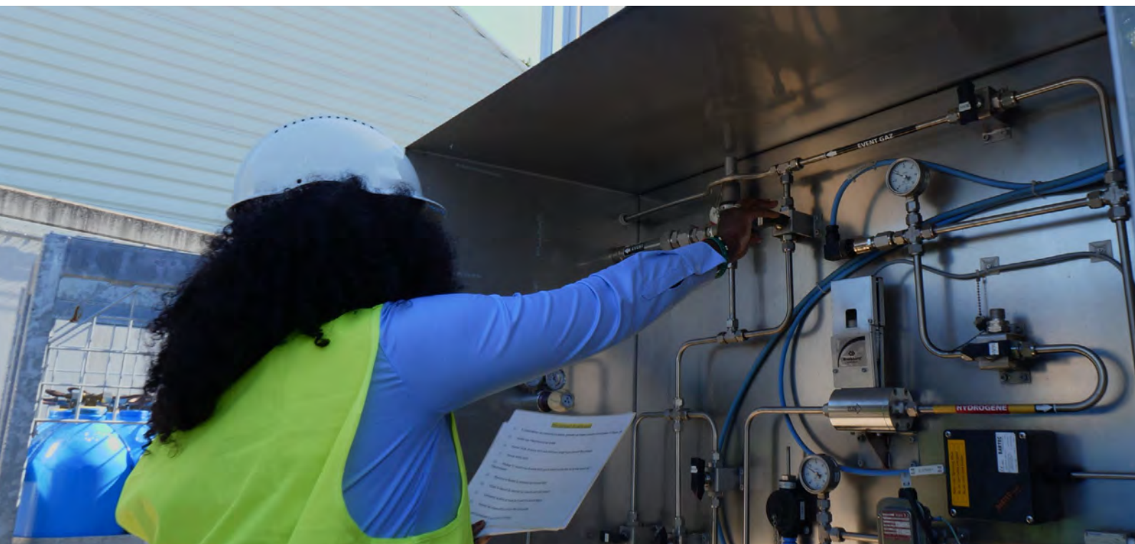
Opération de maintenance sur une installation de production et de distribution d'hydrogène à Sarreguemines (station FaHyence)
